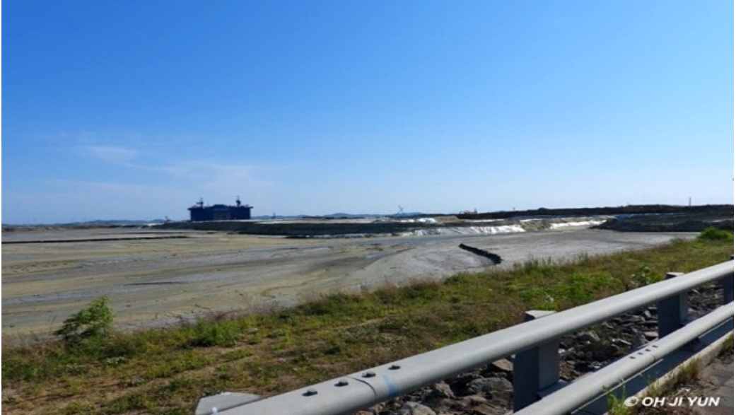
그림 14. 10공구 해안쪽의 외측 우수지의 매립된 모습(2022.5.15. 전경).
